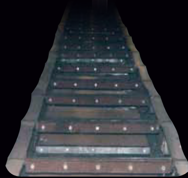
Waste conveying Évacuation des déchets
